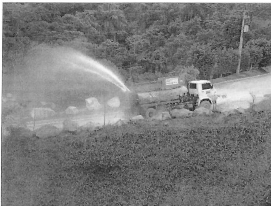
Figura 5 - Caminhão pipa umectando via não pavimentada. (fonte: Prominer Projetos Ltda)
