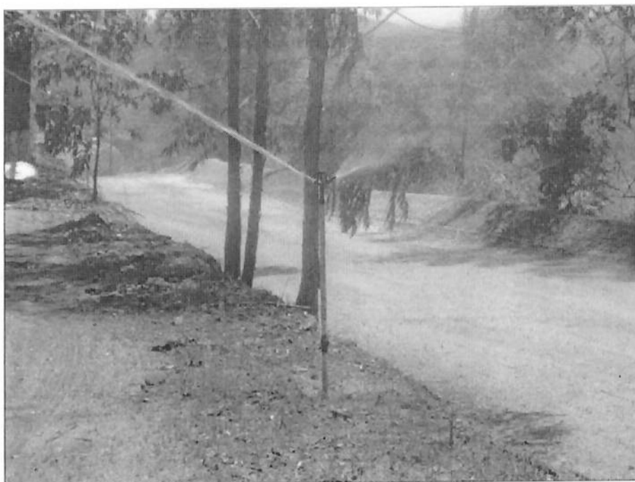
Figura 11 - Aspersor giratório umectando via não pavimentada.
